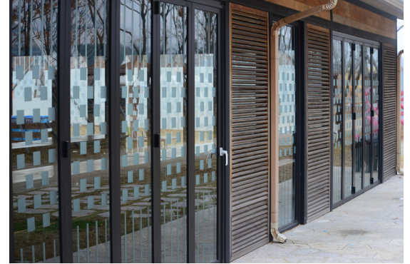
국립생태원 관람객 휴게실에 설치한 UV 반사스틱커. 이 건물은 조류 서식지 한복판에 설치되어 조류 유리창 충돌위험도가 매우 높은 건물이었다. ABC 반사 테이트를 부착한 이후에는 단 한 건의 충돌사고도 보고된 바 없다.
