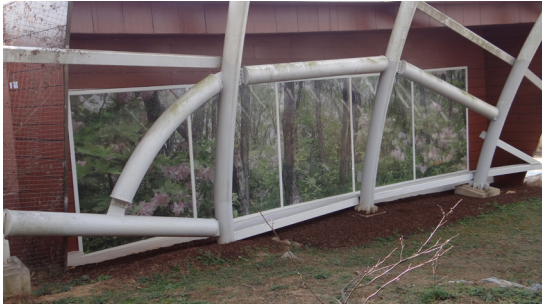
타공필름을 부착한 국립생태원 맹금류 전시장의 실내(A)와 사육조류장 내측(B) 모습. 관람객이 전시장 내부를 관찰함에 있어 아무런 장애에 없으며, 전시 조류들이 유리창 내부를 볼 수 없으므로 유리창 충돌을 근본적으로 예방함과 동시에 동물 스트레스를 경감시키는 기능도 있다.
