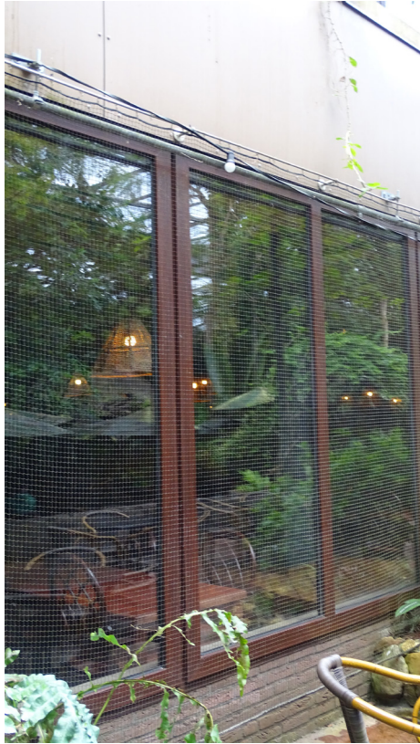
유리창 앞에 설치한 충돌방지 그물망. 유리창과의 직접적 충돌을 완충하기 위해, 그물망과 유리창은 최소 5cm 이상은 띄워서 설치하는 게 좋다. 그물코는 주변 서식조류 크기에 맞게 작은 크기를 선택한다. 그물을 사용할 경우에는 새가 그물 뒤편에 걸릴 가능성이 있으므로 주기적으로 점검하는 것도 필요하다.
