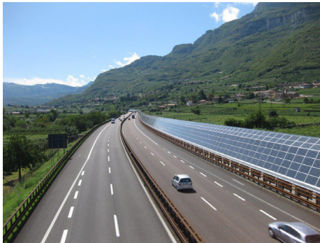
이탈리아 브렌네로시를 지나가는 A22 도로변의 태양광 전지판넬형 방음벽. 기술 발달은 태양광 전지필름도 생산하고 있으며, 기존 건물에 도입 시 온실가스를 줄이고 지구온난화를 낮추는데도 도움이 될 수 있다.
