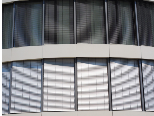
유리창에 맞춰 설치한 블라인드 등도 근처 풍경 반사를 줄이는데 도움이 된다. 여기에는 방충망도 좋은 예방책이 될 수 있다.
