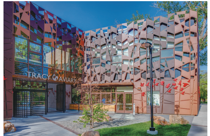
The Tracy Aviary의 신규 LEED Gold 방문자 센터 건물은 LEED 조류 충돌 방지조항 요구사항에 맞춰 지었다. 데칼과 스크린 등을 사용하여 건축하였다.
