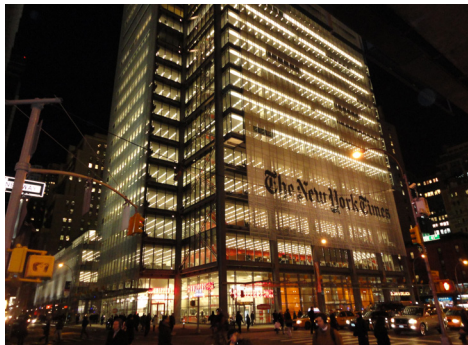
뉴욕타임즈 건물 전면은 FXFOWLE와 Renzo Piano가 설계한 세라믹 막대로 장식하였다. 실내에 있는 사람들이 바깥을 조망하는데 무리가 없으면서 유리가 최소한으로 노출될 수 있도록 하여 열과 빛을 손쉽게 조절하고 새들에게도 안전할 수 있는 건물로 만들었다. 사진: Jleon, wikipedia
