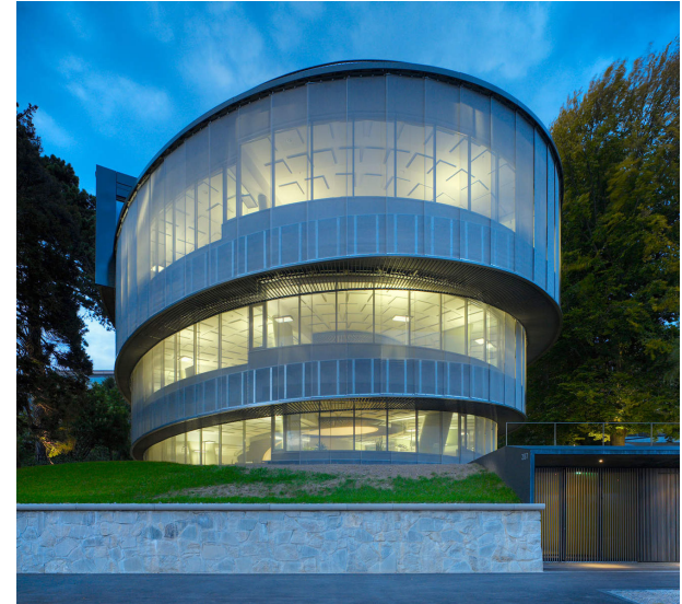
Camenzind Evolution, Ltd가 설계한 금속 메시로 외관을 장식한 스위스 취리히의 Cocoon 건물이다. 이러한 디자인은 사생활을 보장하고 냉난방 비용을 줄여주며 새들을 보호함과 동시에 실내 사용자가 외부를 조망하는데 문제가 없다.
